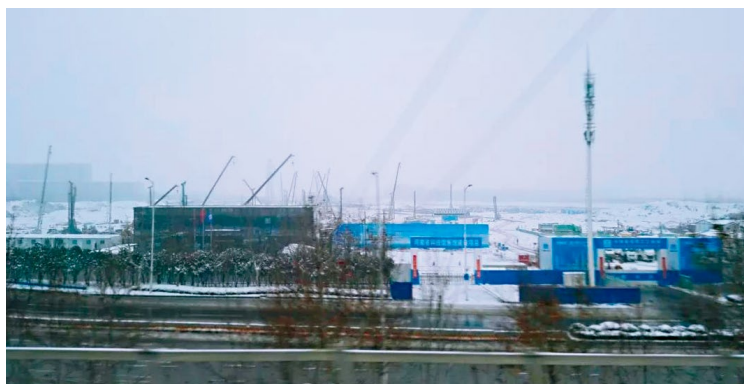
大雪覆盖下的河南省科技馆新馆施工场地
