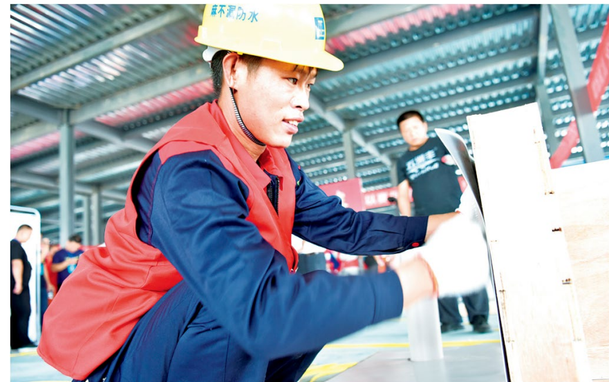
防水施工现场
