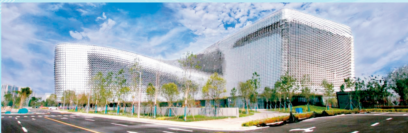
正在建设中的省科技馆新馆。河南日报记者 尹江勇 摄
